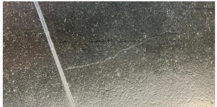
**Zudem sind viele Risse mikroskopisch fein. Um überhaupt Instandsetzungsprodukte einbringen zu können, müsste die Schadstelle mechanisch aufgeweitet oder ausgefräst werden. Das wiederum führt zu sichtbaren Spuren, vor allem bei Streiflicht oder glänzenden Oberflächen.**
